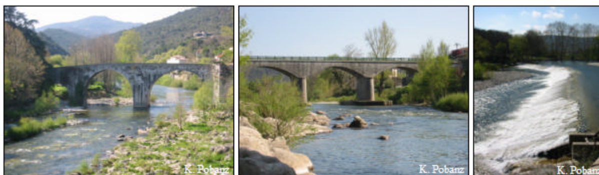
Figure 5. De gauche à droite : Pont Vieux de Ganges, Pont Neuf de Ganges et Seuil de Laroque
